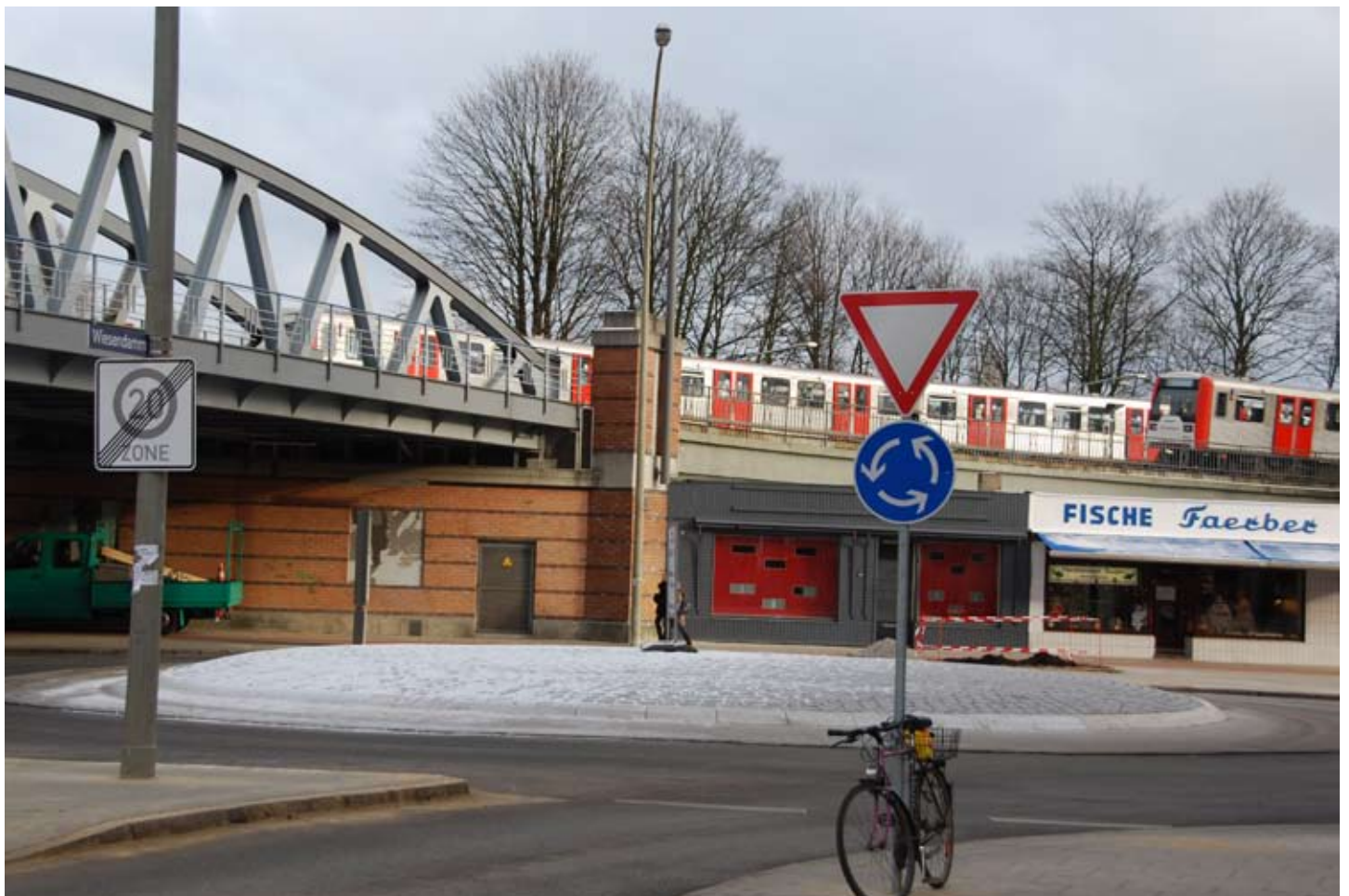
Kreisverkehr Fuhlsbüttler Straße / Wiesendamm
