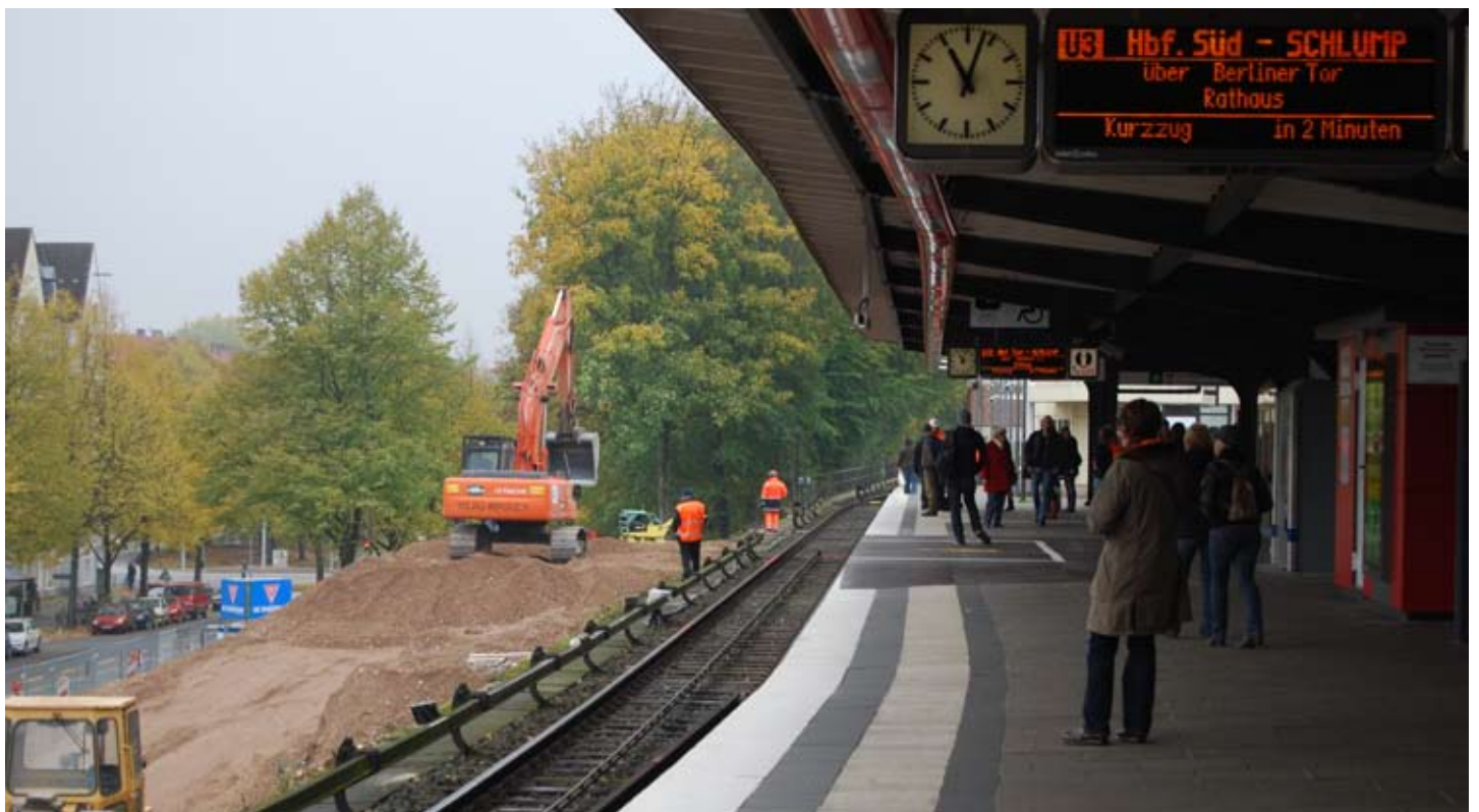
Beginn der Umbauarbeiten am Barmbeker Bahnhof
