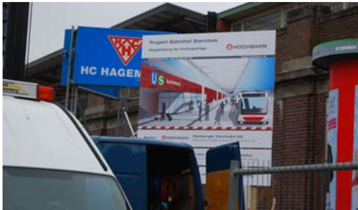
Viel los beim Umbau des Bahnhofes
